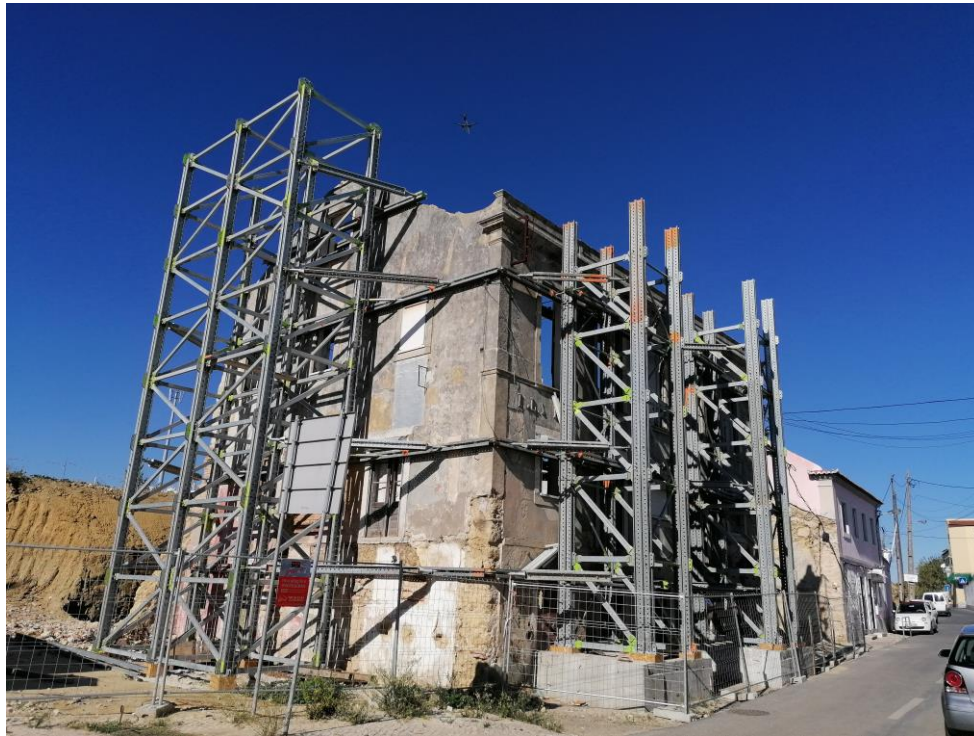
Rua dos Trabalhadores Rurais 16 a 24 – Vila Rita (obra a decorrer)
