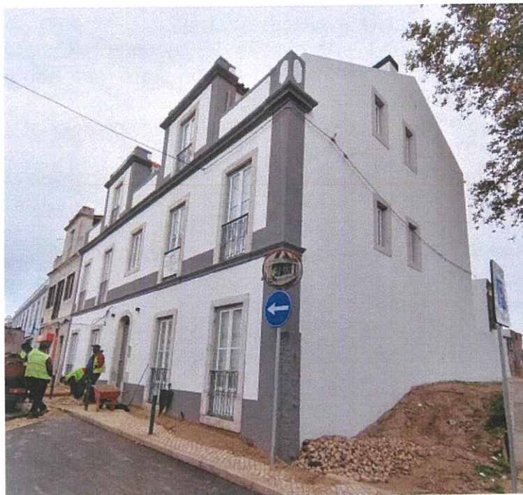
Rua dos Trabalhadores Rurais, 30 a 38 (obra a decorrer)
