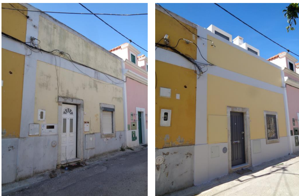
Rua da Ermida, 5 (antes e depois das obras)
