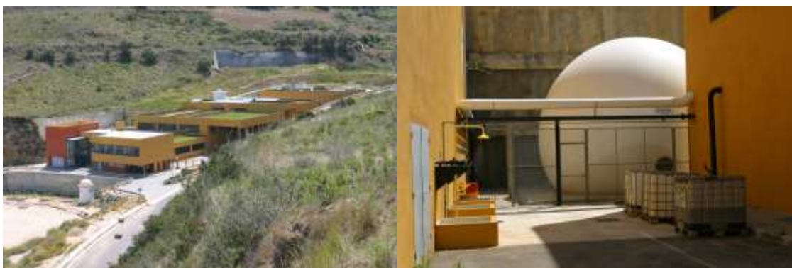
Figura 7.17 ETAR do Portinho da Costa e um dos seus dois Gasómetros com 200 \text{m}^3 de capacidade. (Fonte: SMAS Almada, 2005)
