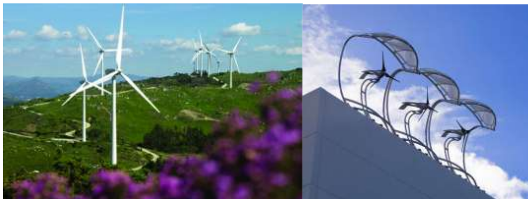
Figura 7.11 Parque eólico e micro-turbinas eólicas no topo de um edifício. (Fonte: AVE e AeroVironment, 2010)
