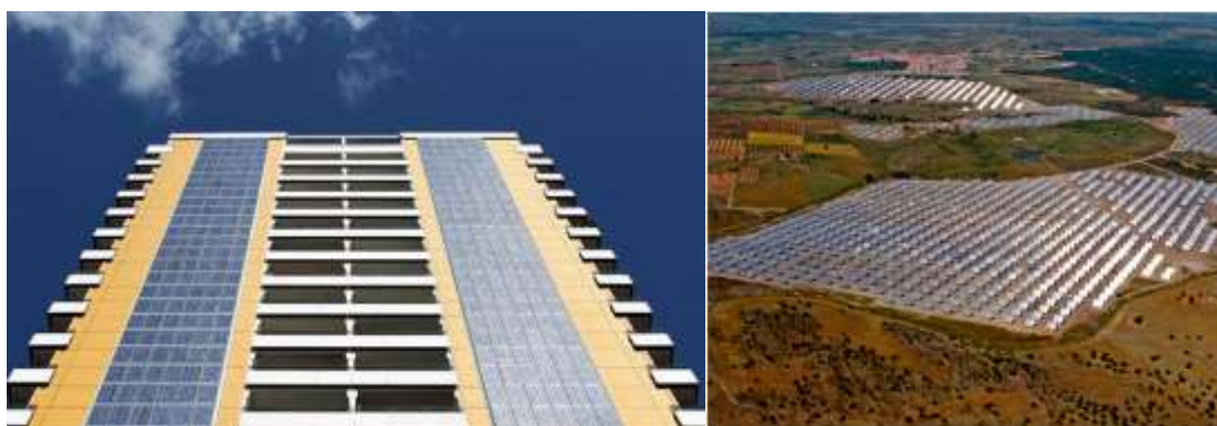
Figura 7.14 Fachada de fotovoltaicos nas Twin Towers de Berlin e Central Solar Fotovoltaica da Amareleja.
